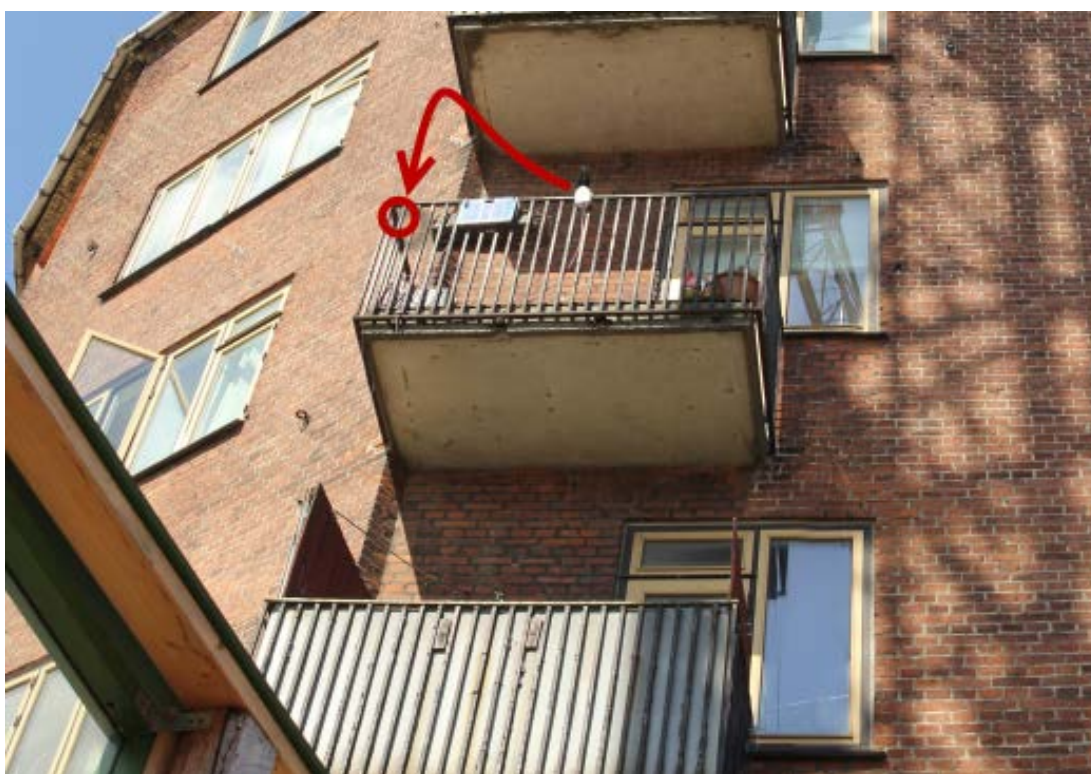
Nørrebro Station. Flytning af NØ2-0 fra altangelænder til murværk.
