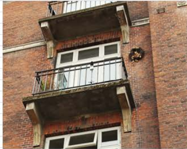
EHP2-0 Enghave Plads
