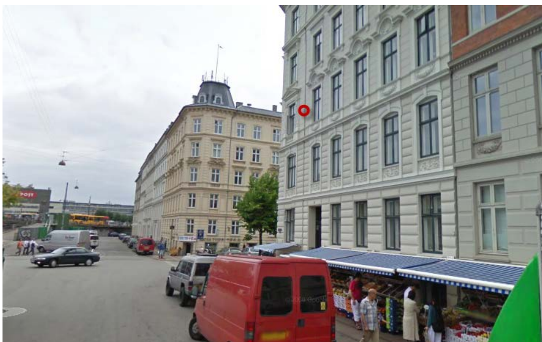
Københavns Hovedbanegård. Placering af ny lydmåler ved Reventlowsgade 22, 3. sal. Kan også placeres på en plade på et af vinduerne til venstre eller højre for murværket. (Fotoet er fra før udgravningen startede).
