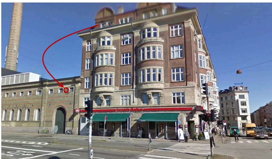
Trianglen. Flytning af TRI2-0 fra 5. sal til facade på Øster Varmeværk.
