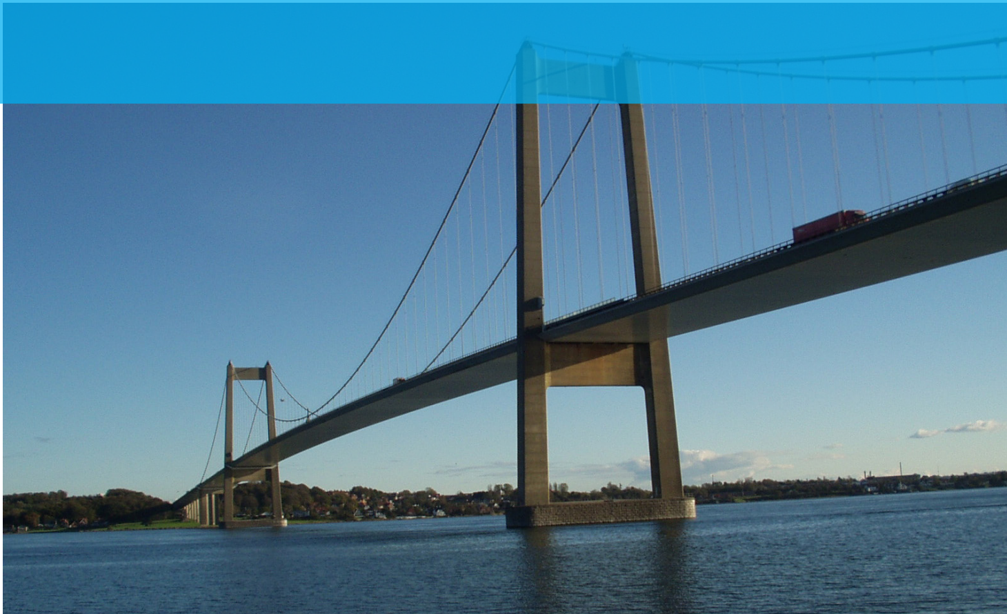
Eksisterende motorvejsbro over Lillebælt
