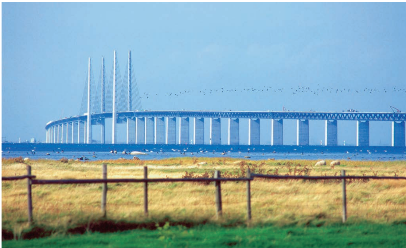
FIGUR 5.2 To-etagers broforbindelse (Øresundsbroen)
