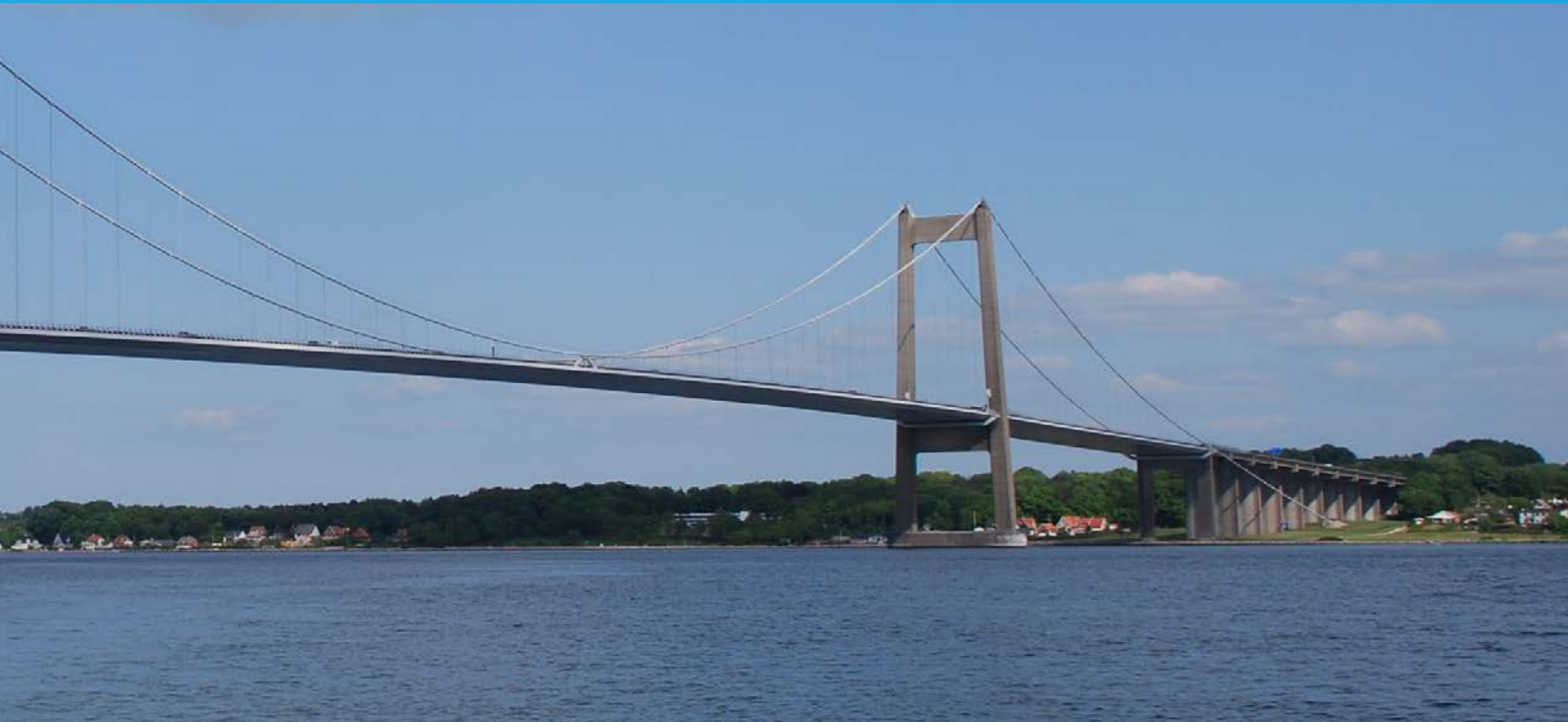
Eksisterende motorvejsbro over Lillebælt
