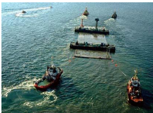
Figur 4-3. Eksempel på transport af sænketunnel element (Øresund).
