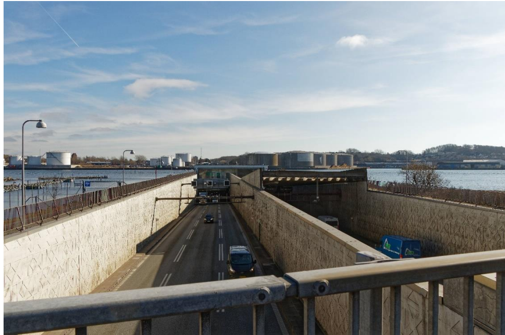
Figur 7.4.11 Eksempel billede for Østlig Ringvej – Billedet er fra Nordjyske Motorvej ved Limfjordstunnelen, set fra Nørresundby siden og er et eksempel på typen af anlæg.
